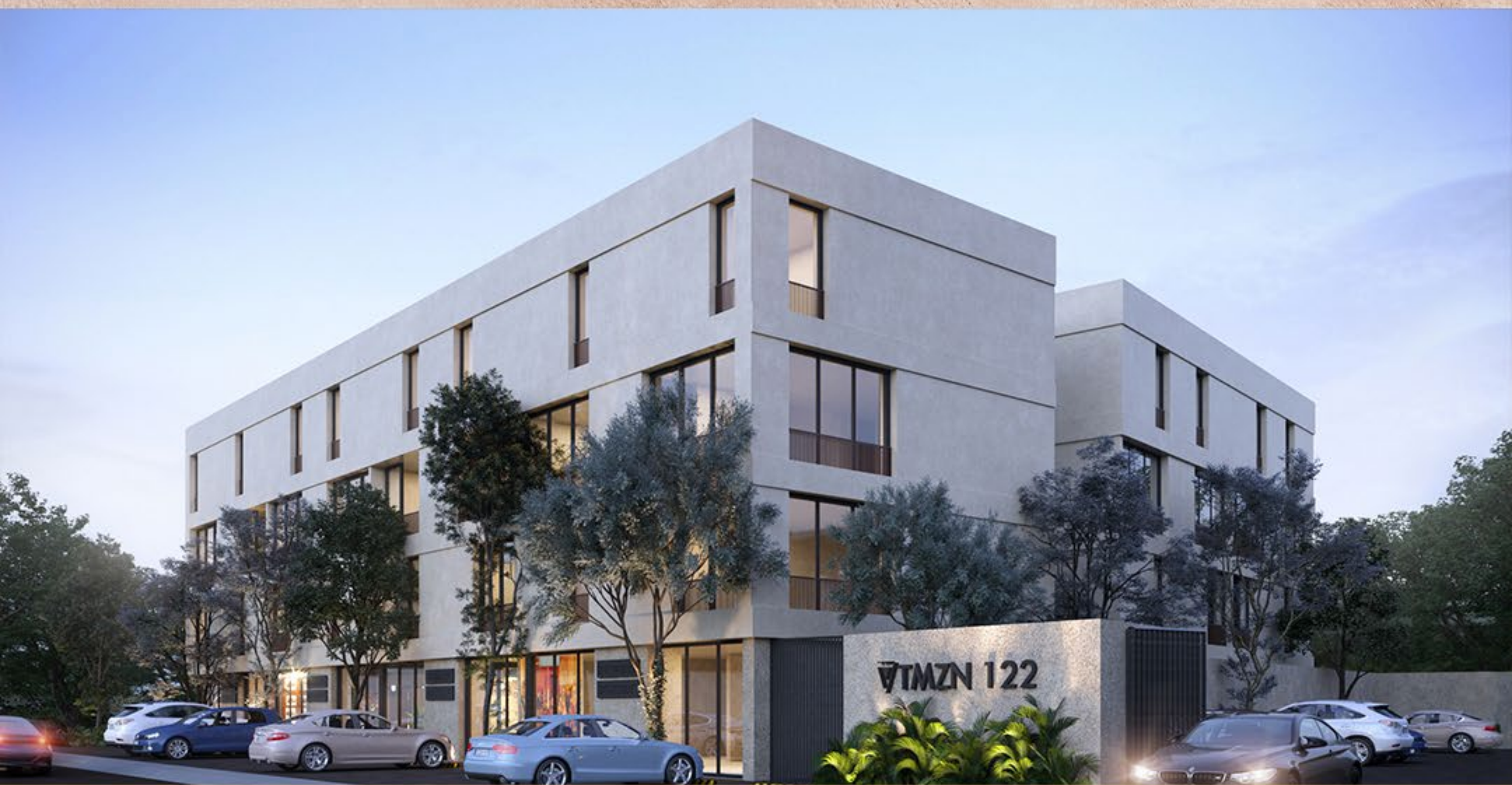
Fachada Posterior/Estacionamiento Privado
