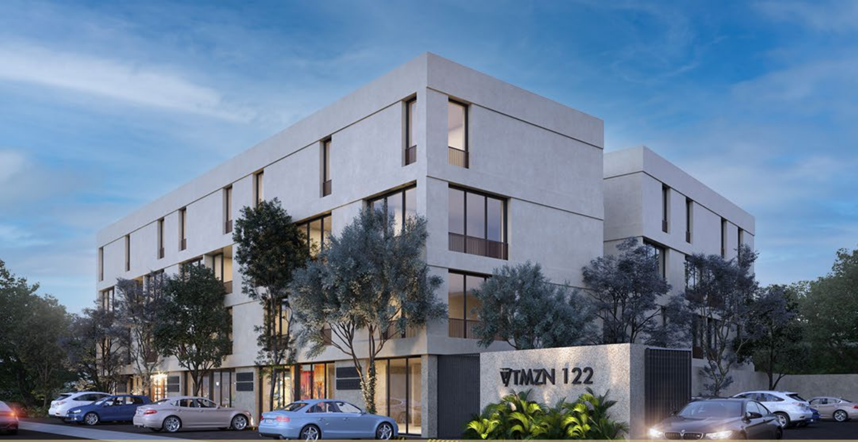
Fachada Posterior/Estacionamiento Privado
